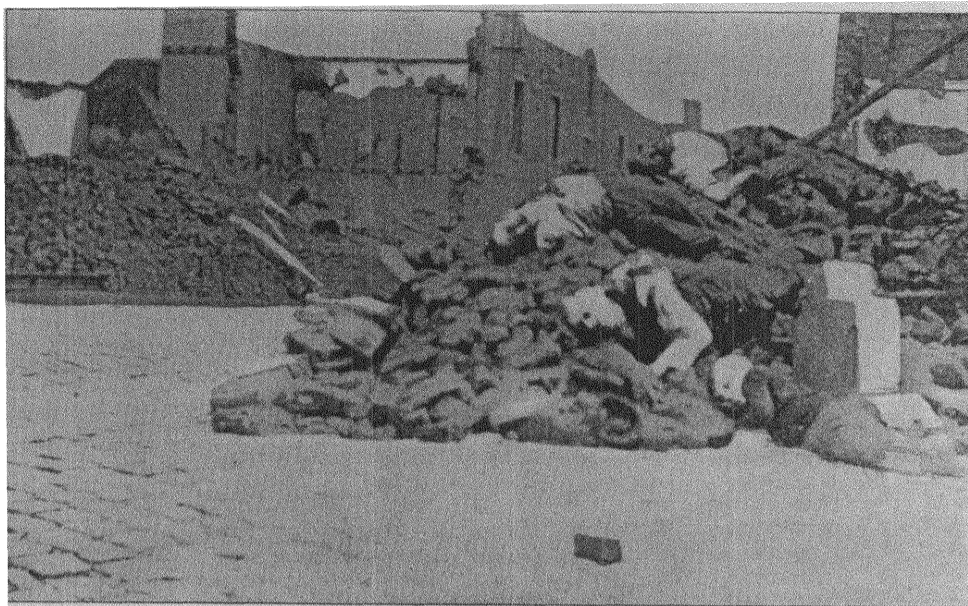
Tamines. Mördade belgier bland spillrorna av brända hus.
