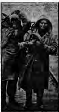
Två unga arbetare vid kraftverksanläggningarna på Döjesträndens. Döjestränd, (U.S.S.R. in Bau)
